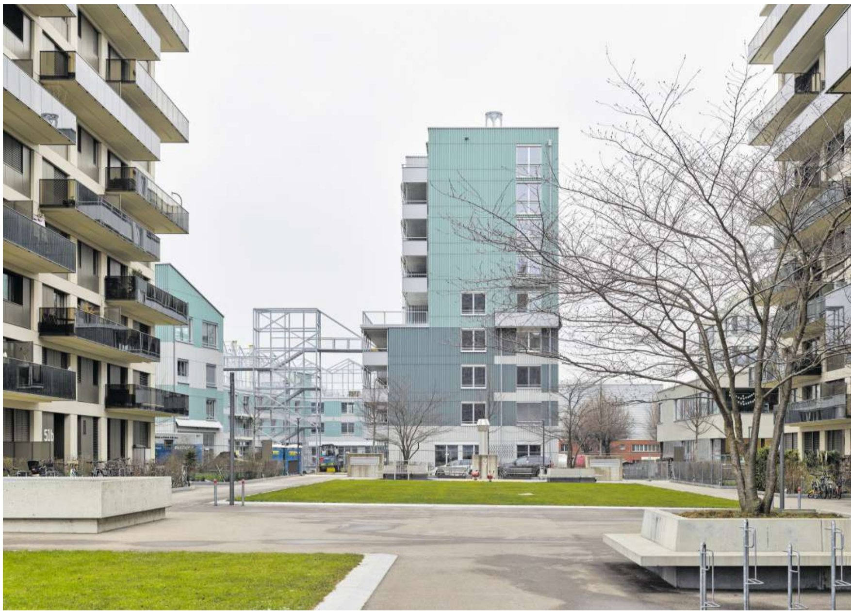
Die Siedlung Westhof in Dübendorf (im Hintergrund) grenzt das Areal gegenüber der S-Bahn ab. Der Treppenturm (Bildmitte) führt zur Dachterrasse mit Pergola. PHILIP HECKHAUSEN
